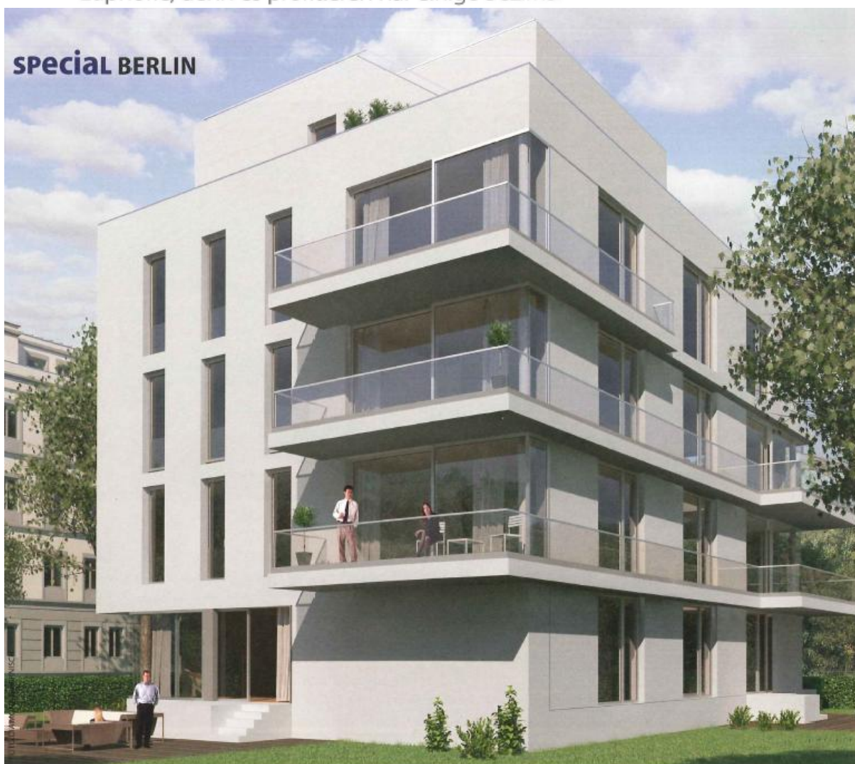
Diplomatenpark heißt die neue Luxusadresse an der Tiergartenstraße: Diamona & Harnisch errichtet dort 32 Eigentumswohnungen.
